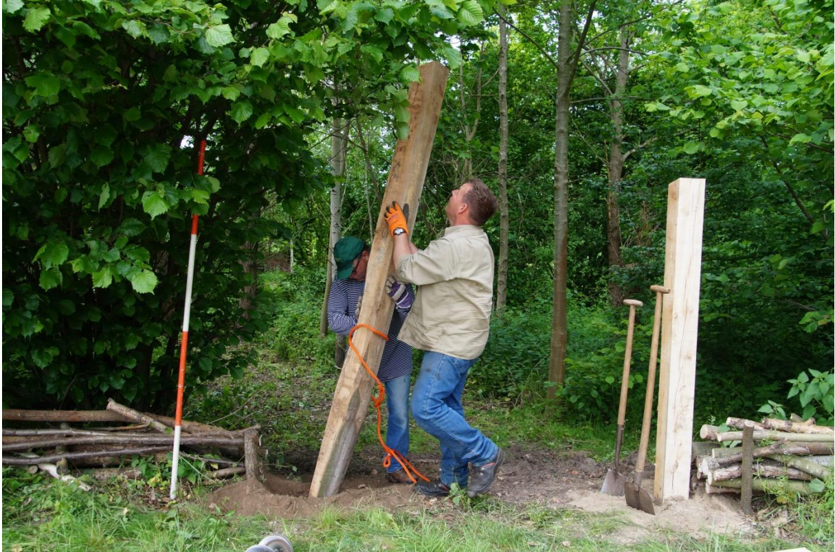
De palen voor het beuken hekwerk worden geplaatst
